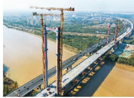
10月28日,在京台高速公路齐河至济南段改扩建工程黄河特大桥施工现场,大桥主塔建设正在有序进行。主桥钢箱梁顺利合龙,桥面施工铺装作业积极推进,为下一步主桥拉索架设施工奠定了坚实基础。
